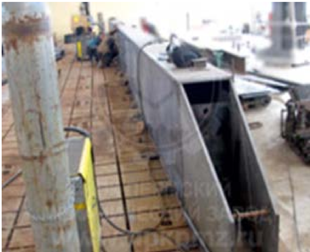
Рисунок 41 – Продольная (грузовая) балка мостового крана, в процессе изготовления
